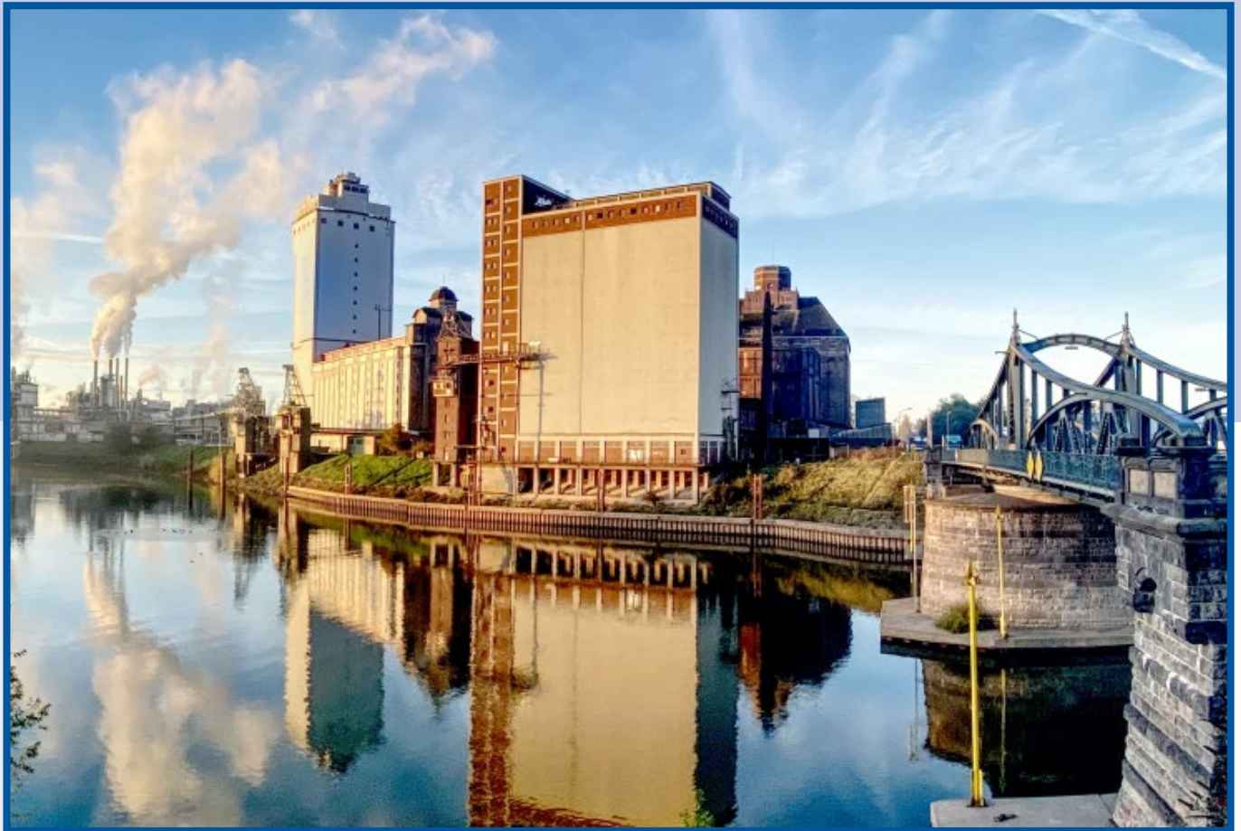
Abb. 1: Drehbrücke Rheinhafen Krefeld (Foto: Christoph Becker, 2020).
