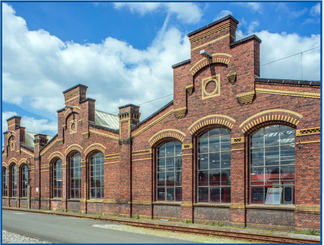
Abb. 6: Eisenbahn-Ausbesserungswerk in Krefeld-Oppum (Foto: Jürgen Gregori, 2017).
