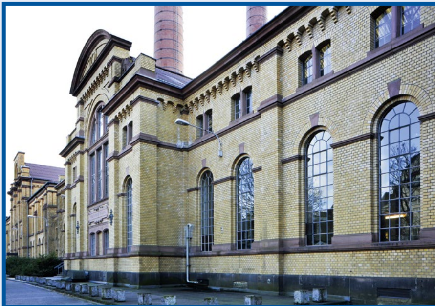
Abb. 2: Kraft- und Wasserwerk Zugweg in Köln-Südstadt (Foto: Jürgen Gregori, 2018).
