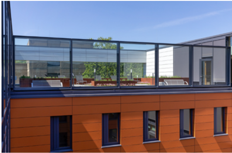
Bild 27 – LVR Klinikum Düsseldorf, Dachterrassenbereich Quelle: LVR-ZMB, A. Hiller
