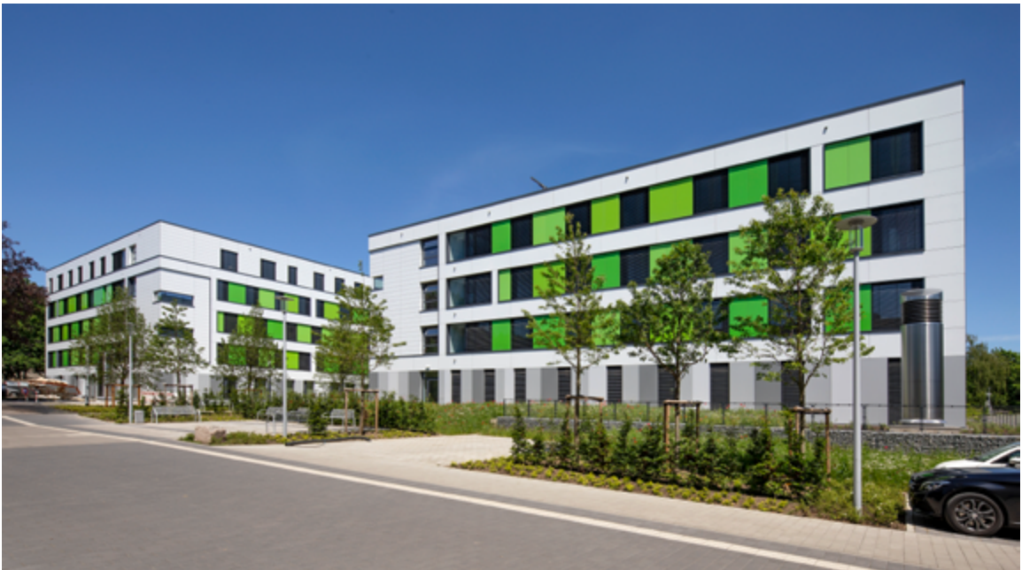
Bild 26 – LVR Klinikum Düsseldorf, Neubau DTFZ Quelle: LVR-ZMB, A. Hiller
