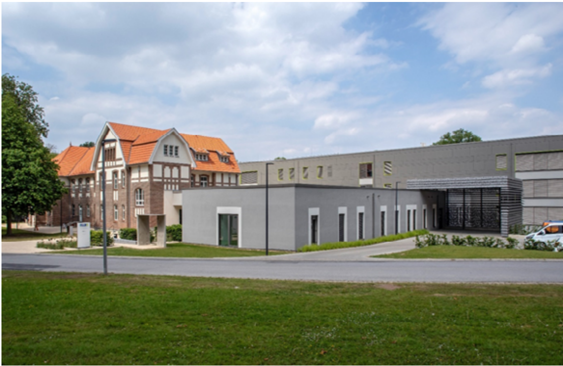
Bild 29 – LVR Klinikum Viersen, Neubau eines Stationsgebäudes Quelle: LVR-ZMB, A. Hiller
