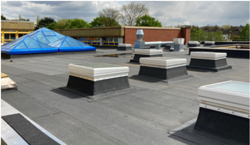
Bild 42 – Flachdachsanierung der Christy-Brown-Schule in Duisburg mit neuen Lichtkegeln
